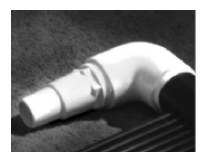
Abb. 5 Schrauben Sie nun die Kniestücke ebenso mit Teflonband zur Abdichtung auf die Gewinde des Sammelrohres mit Markierung . Überdrehen Sie die Kniestücke nicht.
